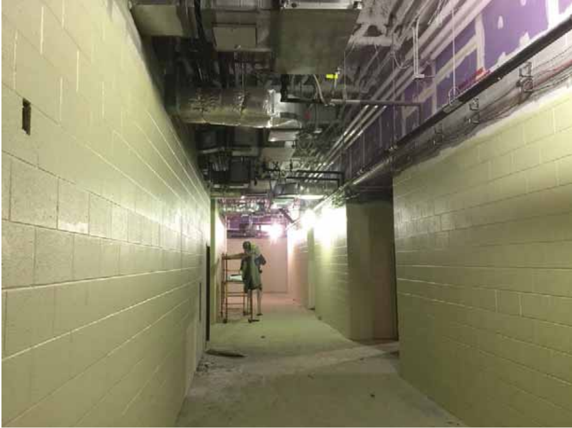
Corridor 3 rd level.
